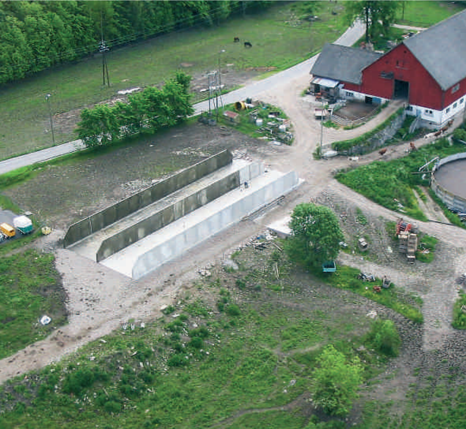
KAPASITET: Siloen har en kapasitet på rundt 570 kubikkmeter ferdig masse. Knut Vasdal har ikke planer om å fylle helt opp.
