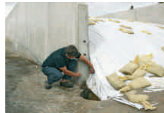
VEGGER: Veggene er kraftig dimensjonerte, 35 centimeter i bunnen og 20 centimeter i toppen. De skal tåle 20-tonns trykk.
