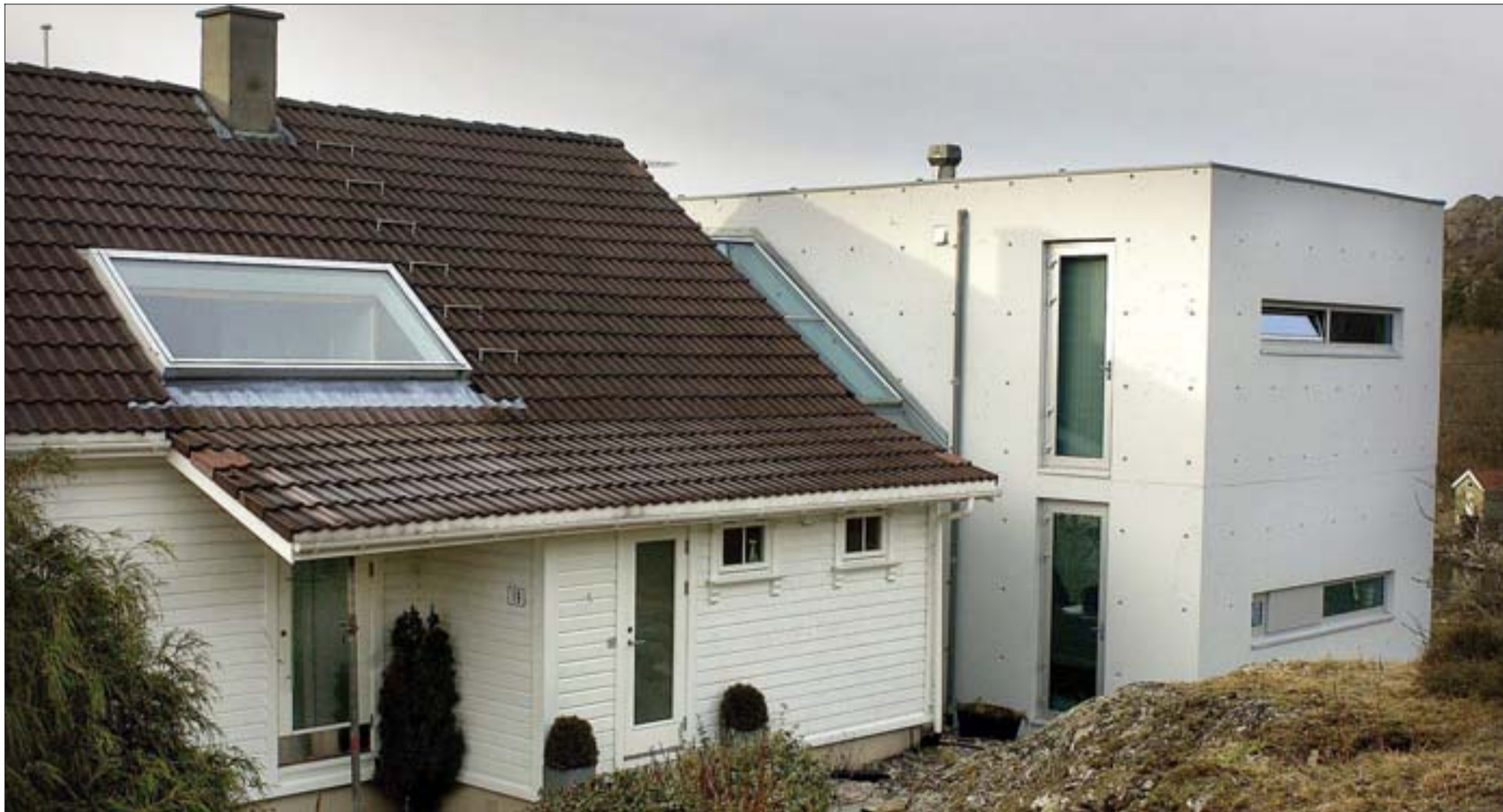
BETONGKLOSS: For få år siden utvidet et par på Lædre i Eigersund huset med et påbygg i betong i flere etasjer. Det er framtidens byggemetode. (Foto: Jan Tore Glenjen)
