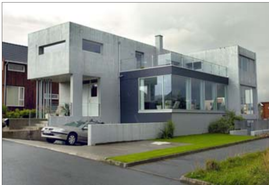
TREKK OG SUS: Det er vanskelig å oppnå et godt innneklima i bygg med store glassflater. Det blir ofte både trekk og sjenerende sus.
